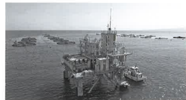
鳥取県境港市に設置された「自動給餌システム」。場所によっては陸上設置も可能だ（日鉄エンジニアリング提供）
